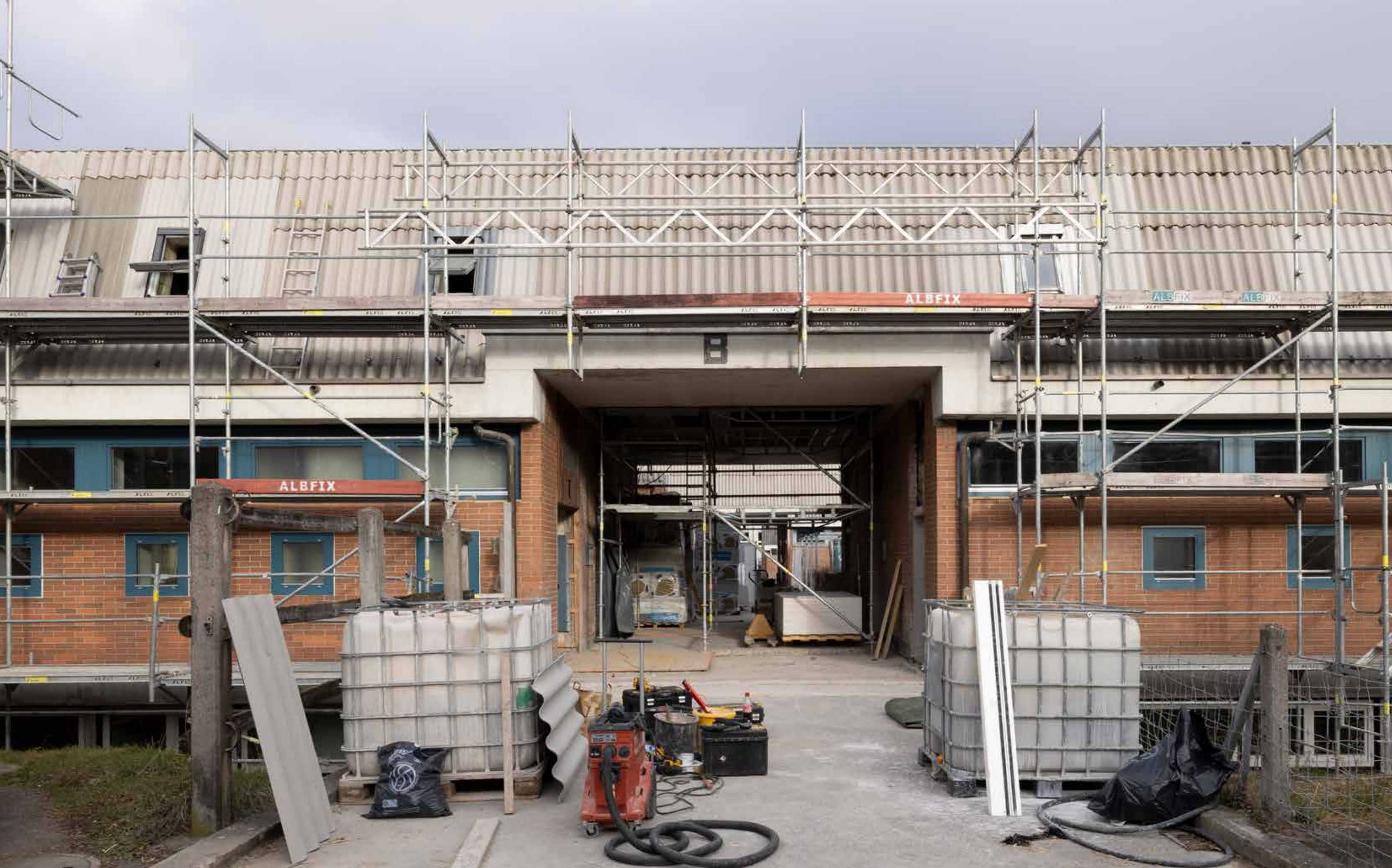
Die stabilisierenden Massnahmen der Pferdeklinik in Zürich schreiten voran. Ein solches Bauvorhaben bei laufendem Betrieb ist mit besonderen logistischen Herausforderungen für Mensch und Tier verbunden.
