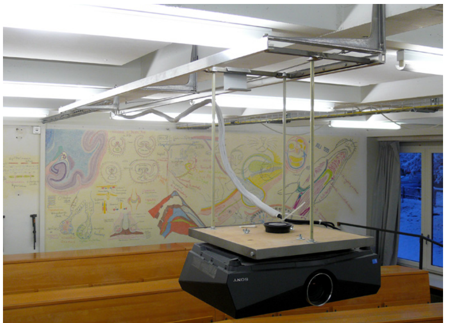
Eine erfindungsreiche Lösung zum Absenken des Beamers für die Projektion auf ein Smartboard.
