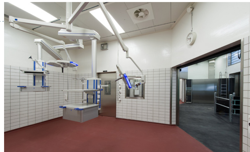
Einer der beiden neuen Operationssäle.
