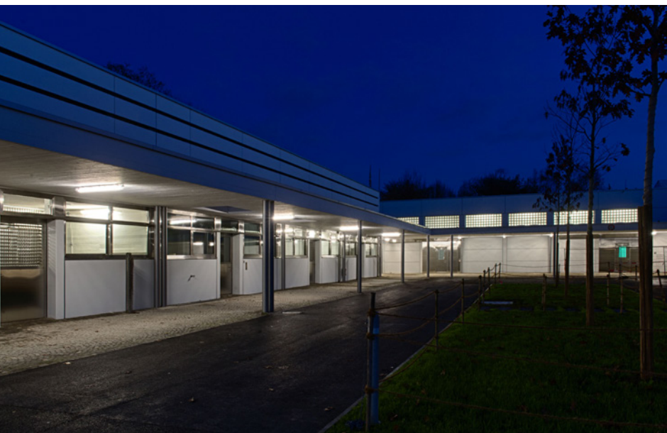
Ansicht auf die Pferdeklinik vom Innenhof (Stalltrakt und OP-Trakt).
