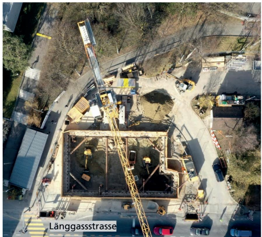
Abbildung 3: Die Baugrube aus der Vogelschau
