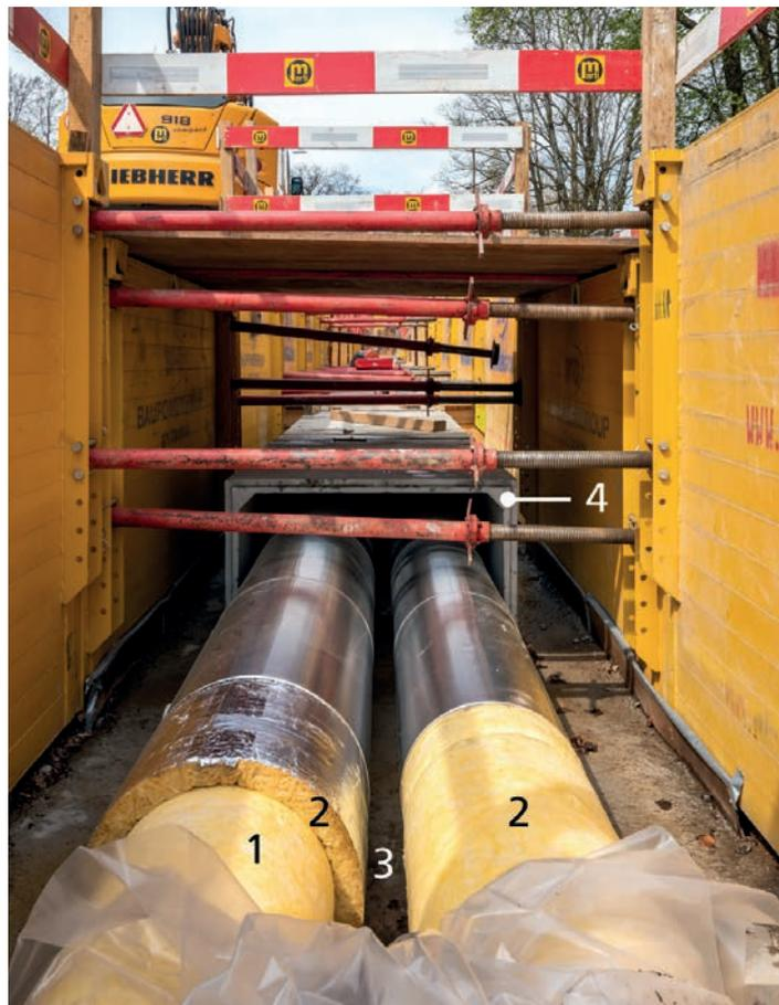
Abbildung 1: Verlegen der Transportleitungen für den Hochtemperaturkreislauf
